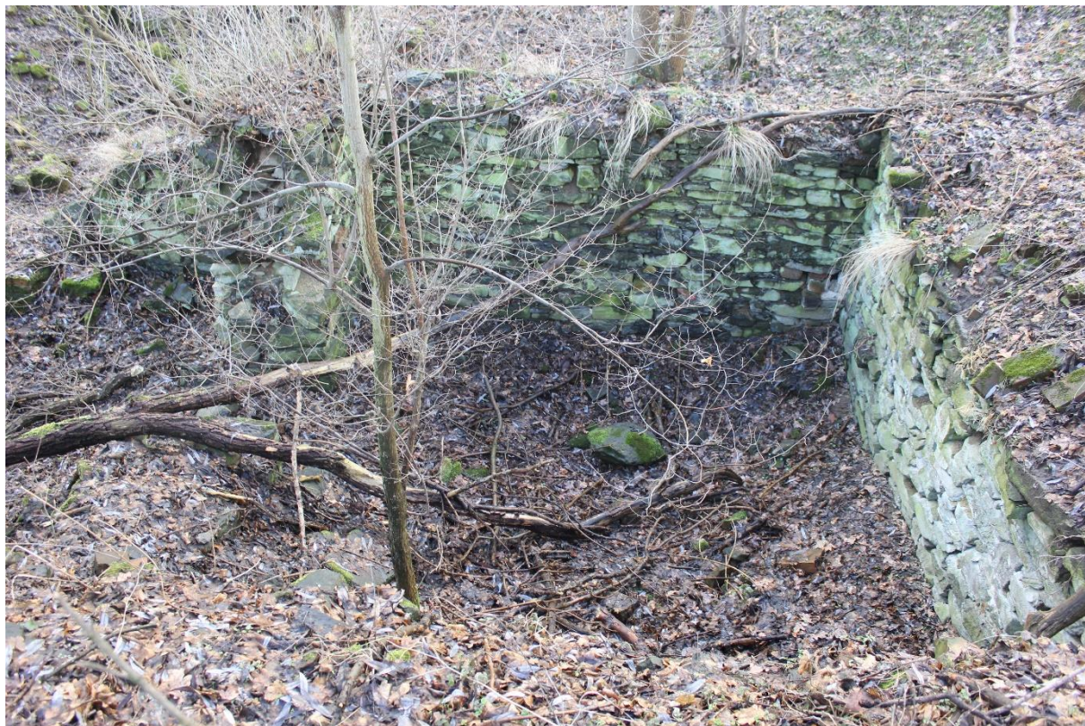
Obrázek č. 1: Konmühle č. p. 88, torzo dolní komory sýpky, foto Kamil Podroužek 2017
