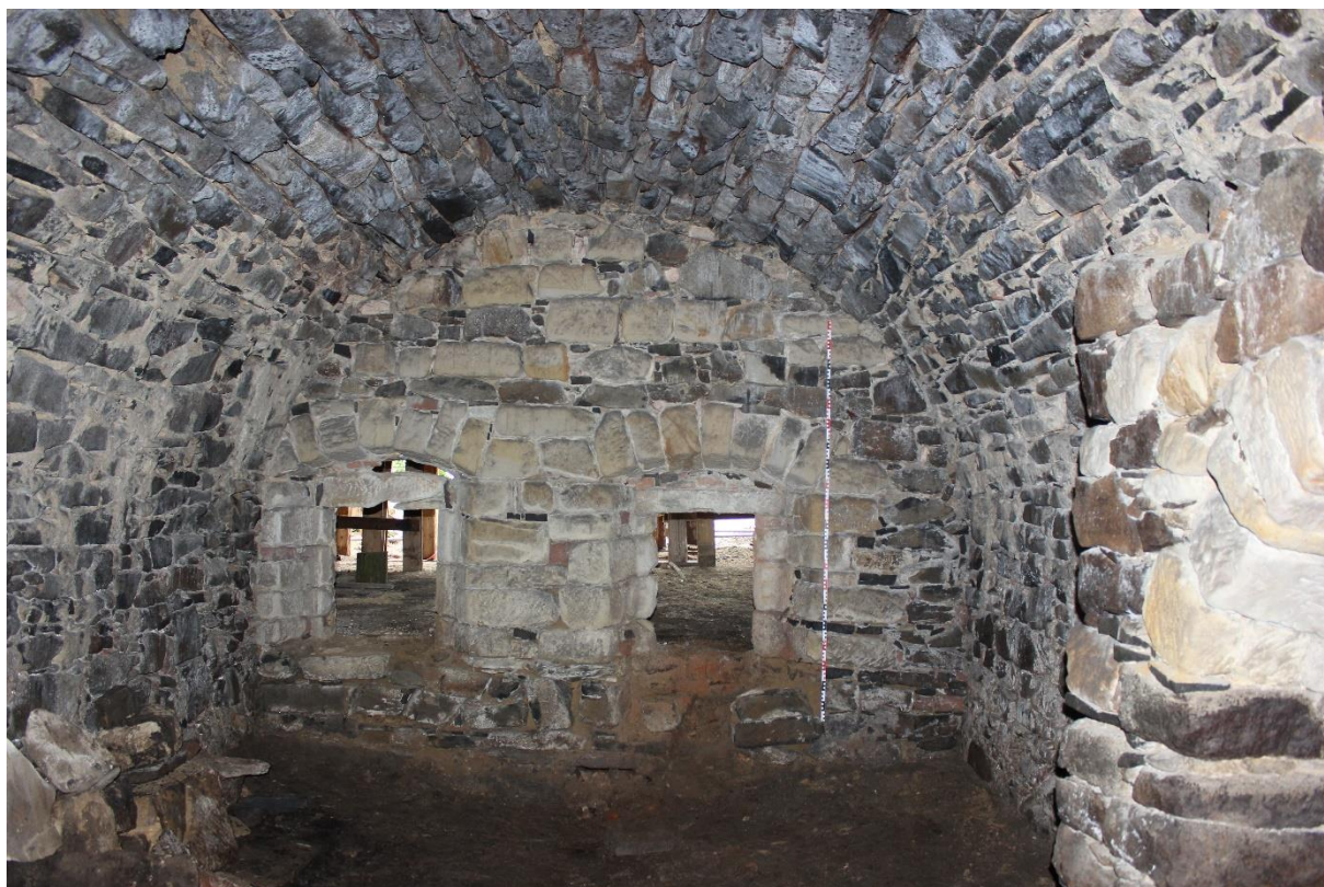
Obrázek č. 1: Severní líc severní čelní zdi druhého sklepa, Kamil Podroužek 2016.
